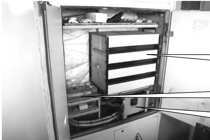
Schrank an der Rückwand von Führerraum 1 (BR 112)
