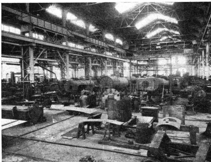
Abb. 43. Kesselschmiede in den Zentralwerkstätten in Oerebro der kgl. schwedischen St.-B.
