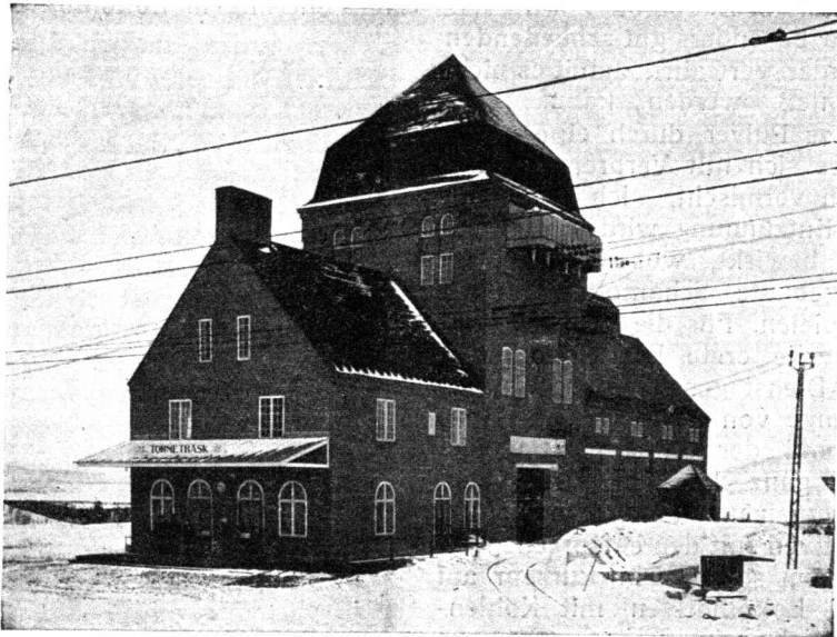
Abb. 21. Empfangsgebäude mit Unterwerk in Torneträsk auf der Linie Kiruna—Riksgränsen.
