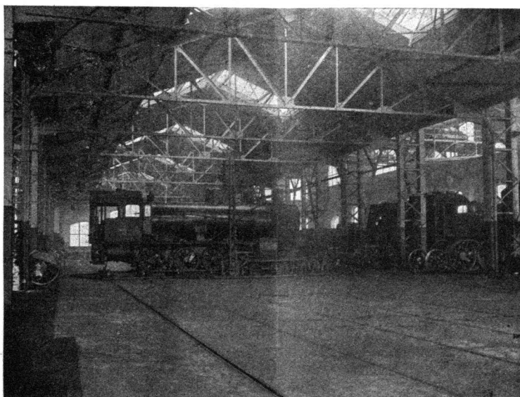
Abb. 45. Schiebebühne der Distriktwerkstatt in Notviken der kgl. schwedischen St.-B.
