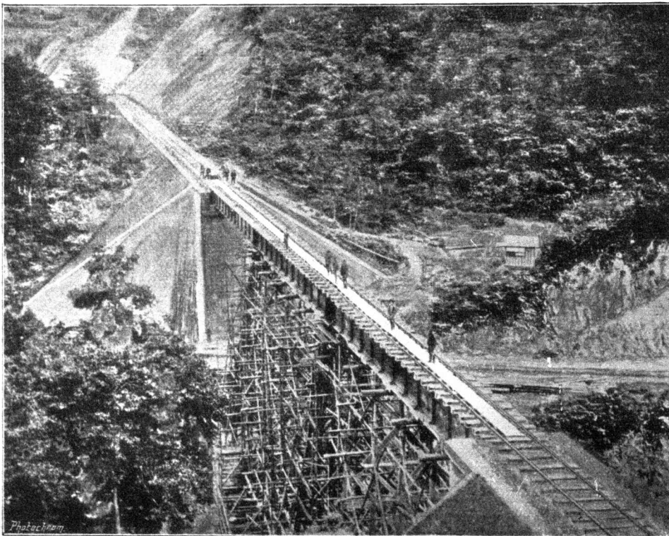
Abb. 5. Gitterbrücke von 70 m Spannweite auf der Hauptstrecke nach Tokio der japanischen St. B.
