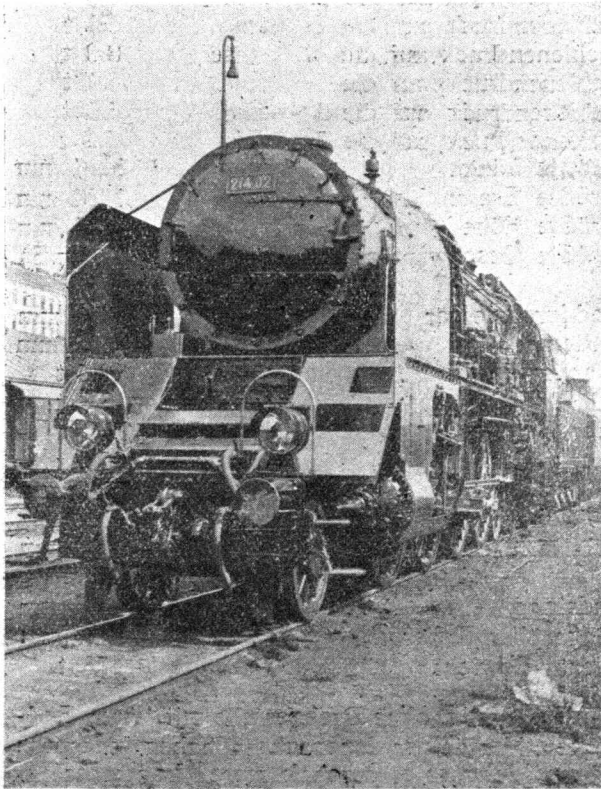
Bild 1. Stirnansicht der 1D2-Heißdampf-Schnellzuglokomotive, Reihe 214 der Oe. B. B. (2. Lieferung)
