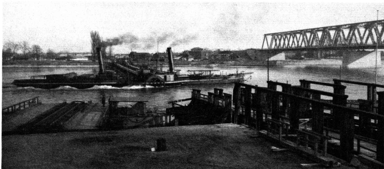
Bild 2: Je drei Durchlaßjochs gaben in beiden Fahrtrassen eine lichte Öffnung von 54,5 m frei
