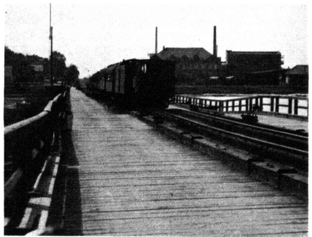
Bild 4: Das Gewicht des Zuges bewirkte eine starke Durchbiegung der Brückenfahrbahn
