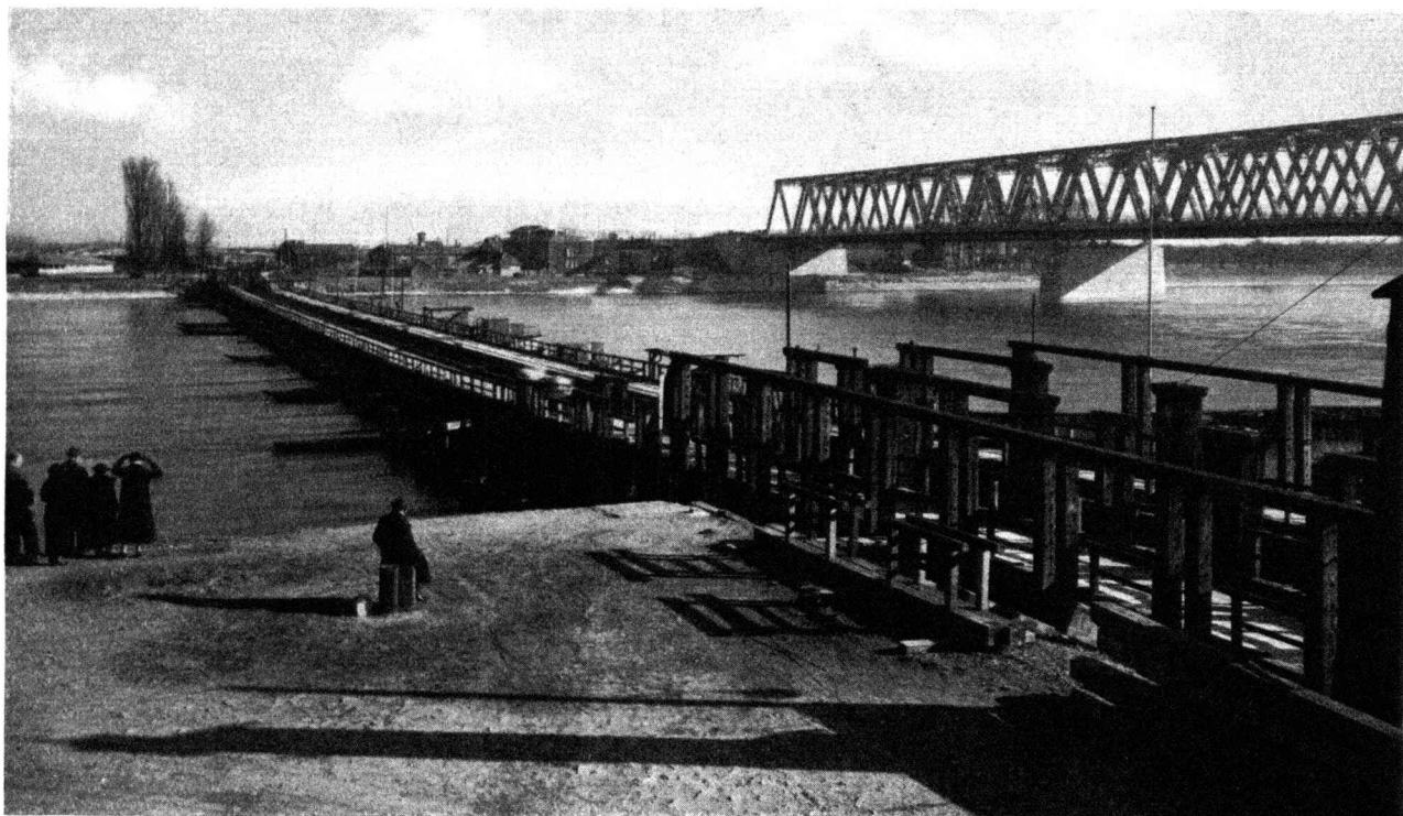
Bild 1: Nach den Plänen von Ober-Ing. Basler wurde 1864—1865 die erste Eisenbahn-Schiffbrücke über den Rhein gebaut
