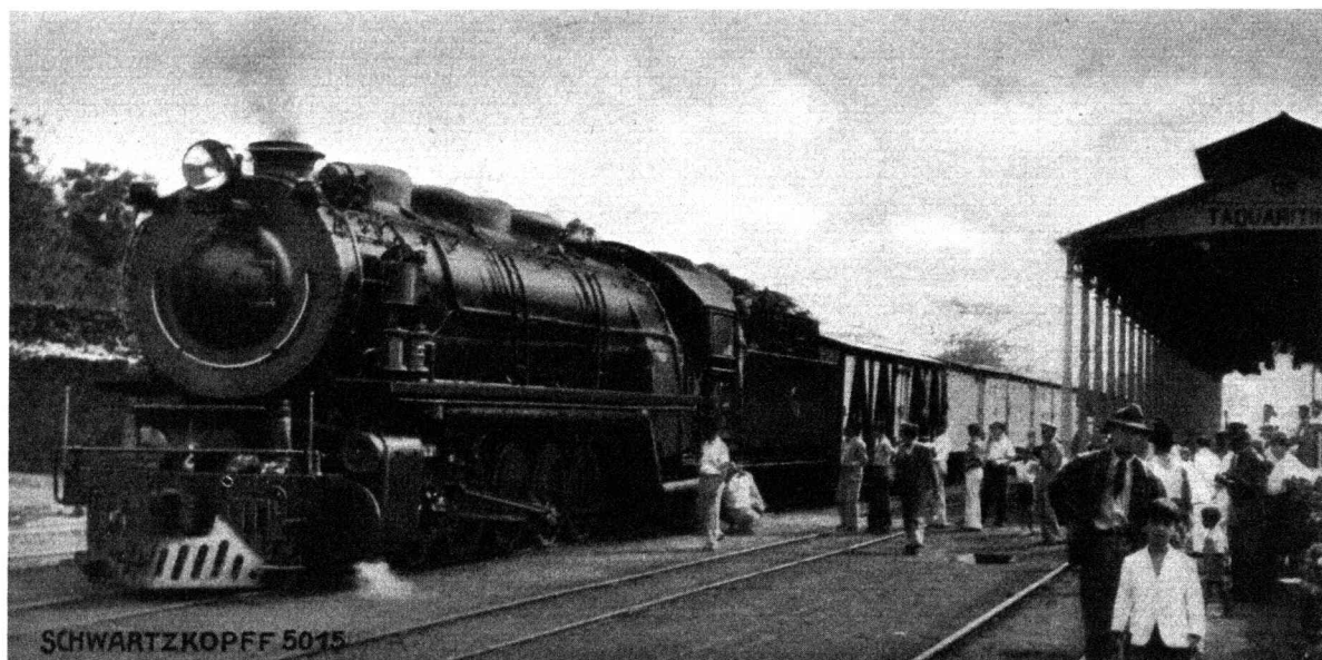
Bild 1: Die 2 E 1 - Heißdampf-Lokomotive verläßt mit einem Güterzug von 630 t die Station Taquaritinga
