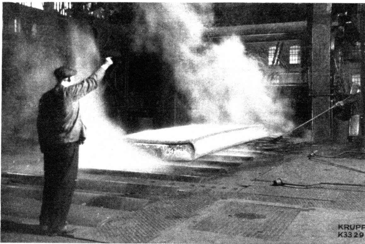
Auswalzen einer Bramme für einen Lokomotiv-Barrenrahmen.
