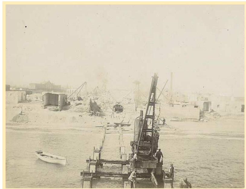
Hinca de pilotes para el embarcadero Bairds, al fondo se puede observar la estación de ferrocarril de Almería, 1915 Fondo Sánchez Picón.
