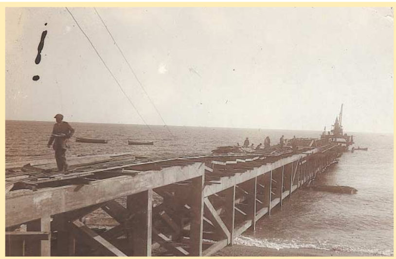
Construcción del embarcadero Bairds, 1915 Fondo Sánchez Picón.
