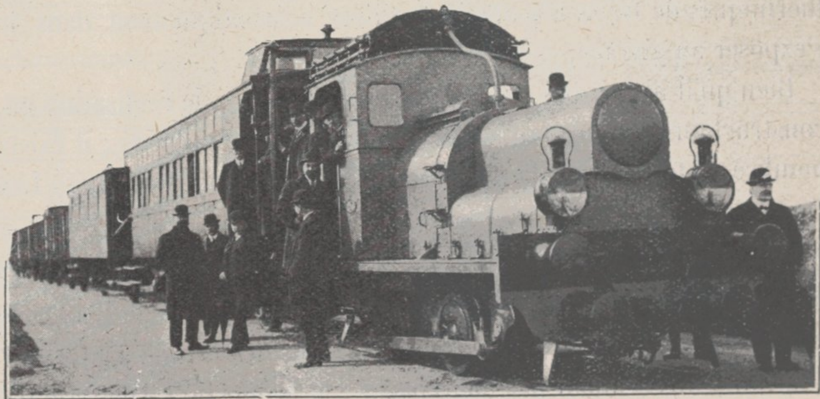
Fig. 120. — LOCOTRACTEUR SCHNEIDER-HAUTIER (Moteur à Naphtaline)
