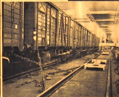
Immobilisation des véhicules est soigneusement réalisée à l'aide de taquets, de chaînes et de vérins.
