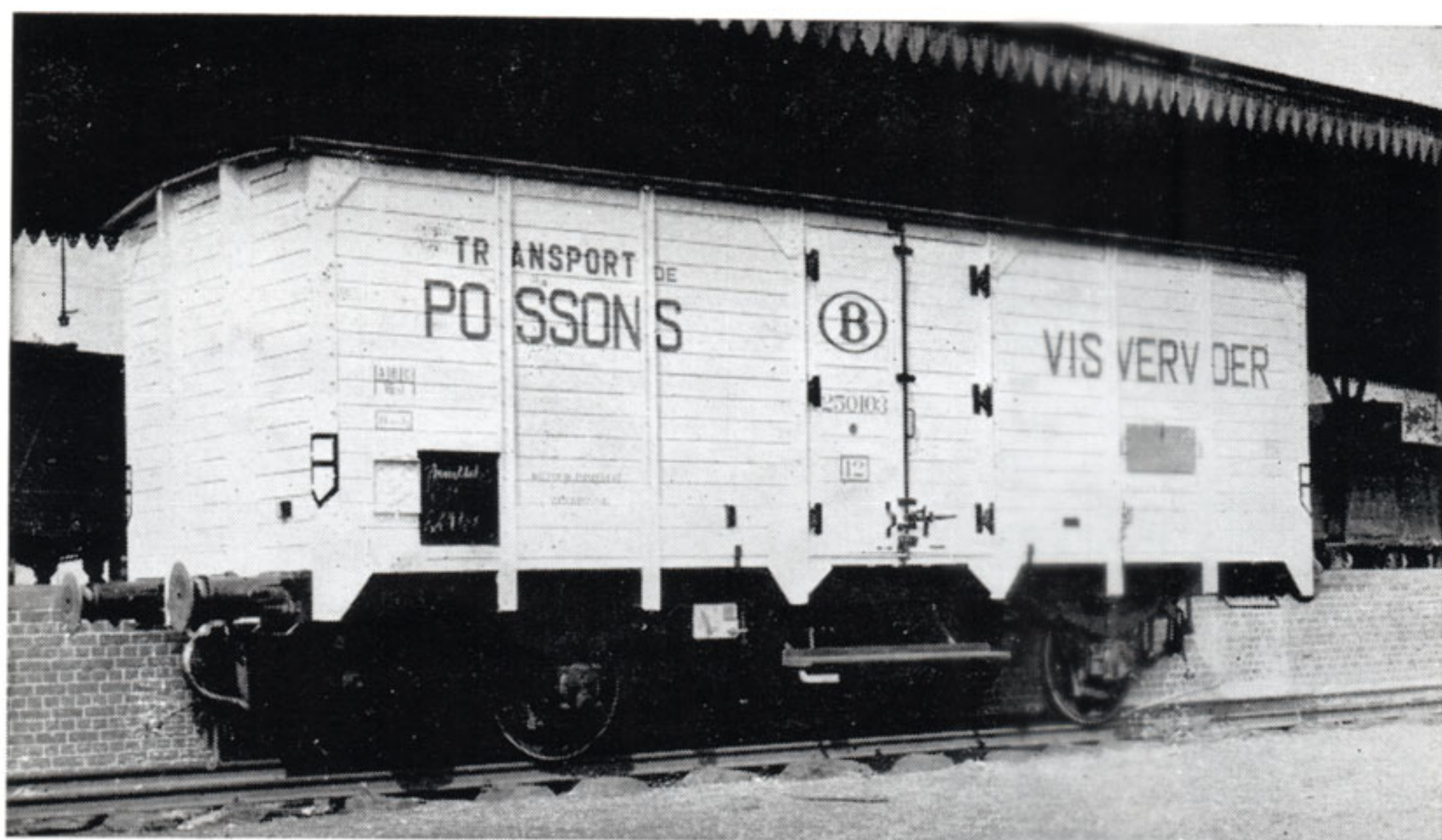
Wagon réfrigérant (série 1.043.100-1.043.224) pour transport de poisson frais.
