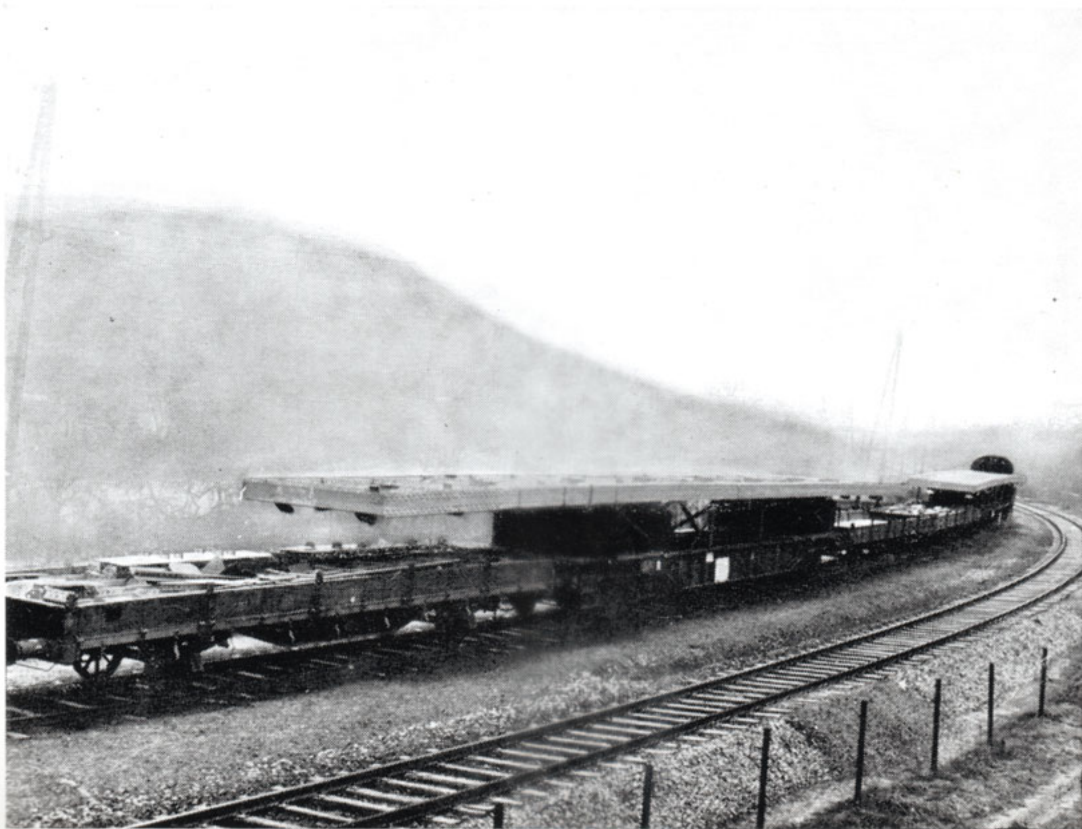
Transport d'éléments de pont sur wagon plat encadré de wagons de sûreté.
