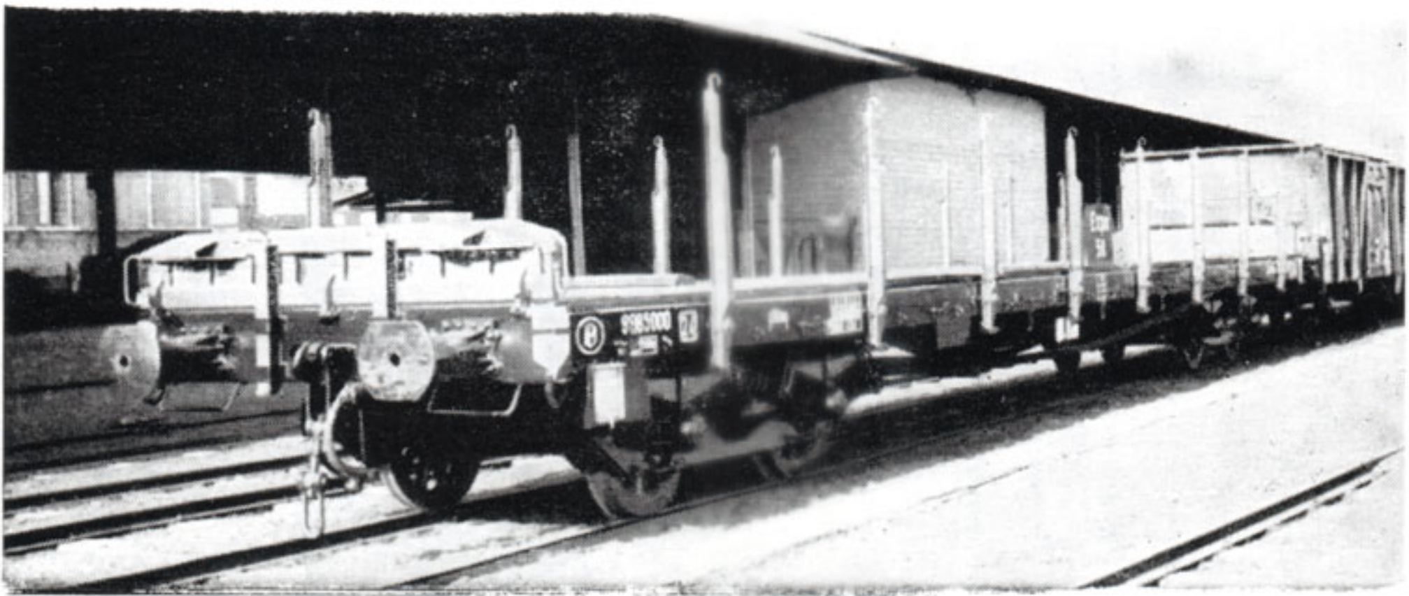
Wagon plat à bogies du type standard U.I.C. (série 9.985.000-9.985.999).
