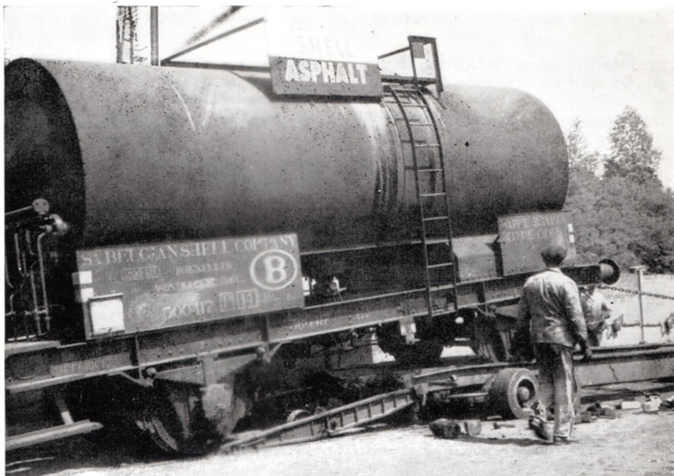
Utilisation d'une rampe mobile pour le déchargement d'un wagon-citerne.
