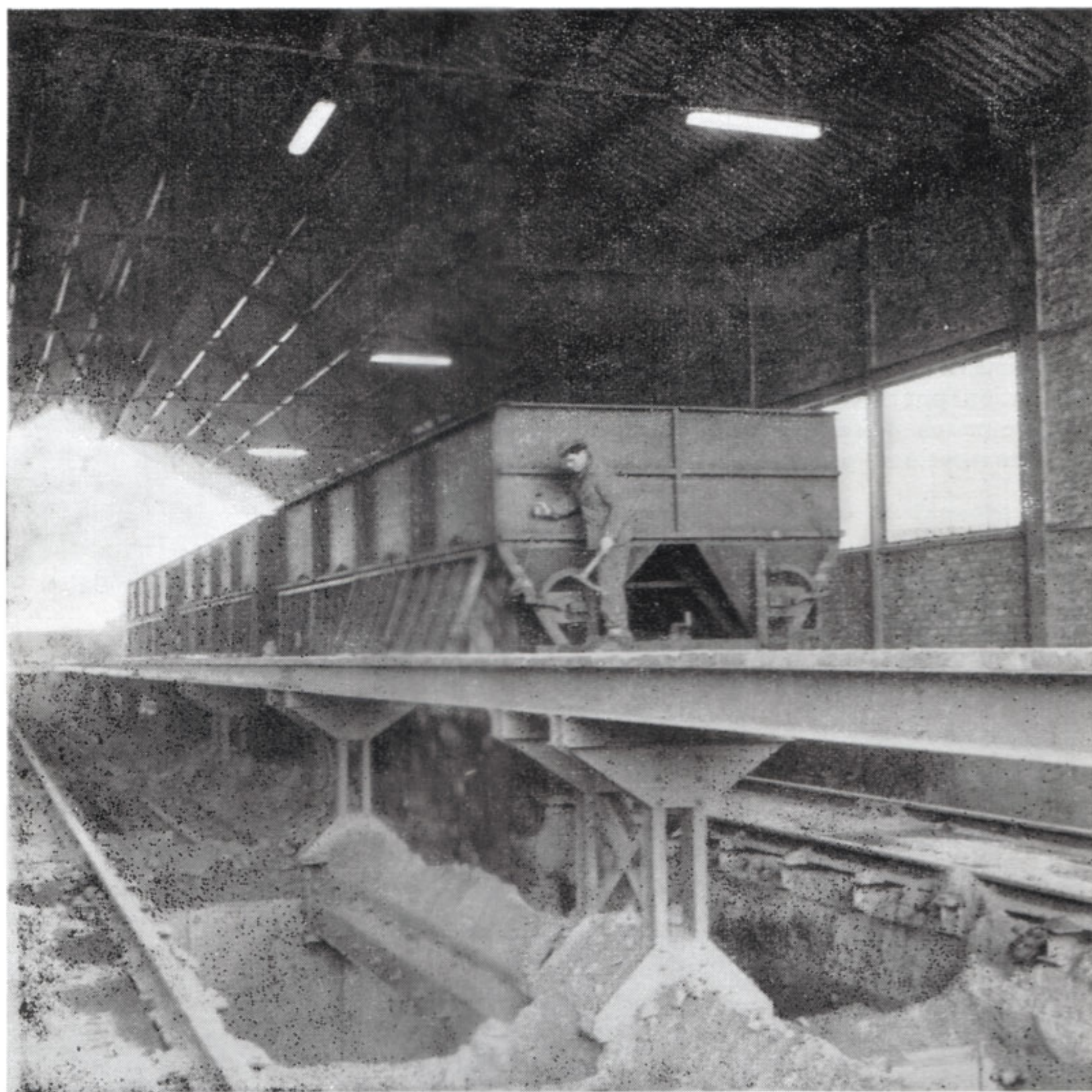
Déchargement par gravité d'un wagon trémie, sur raccordement privé.
