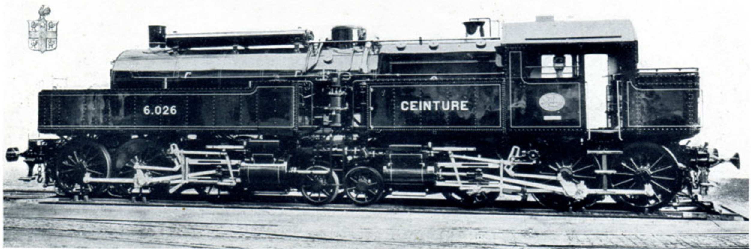
Fig. 53. — Locomotive articulée « Du Bousquet » construite en Belgique pour les Chemins de Fer de Ceinture de Paris. Poids à vide : 76.300 kg. Poids en service : 84.000 kg. Poids adhérent : 73.600 kg.
