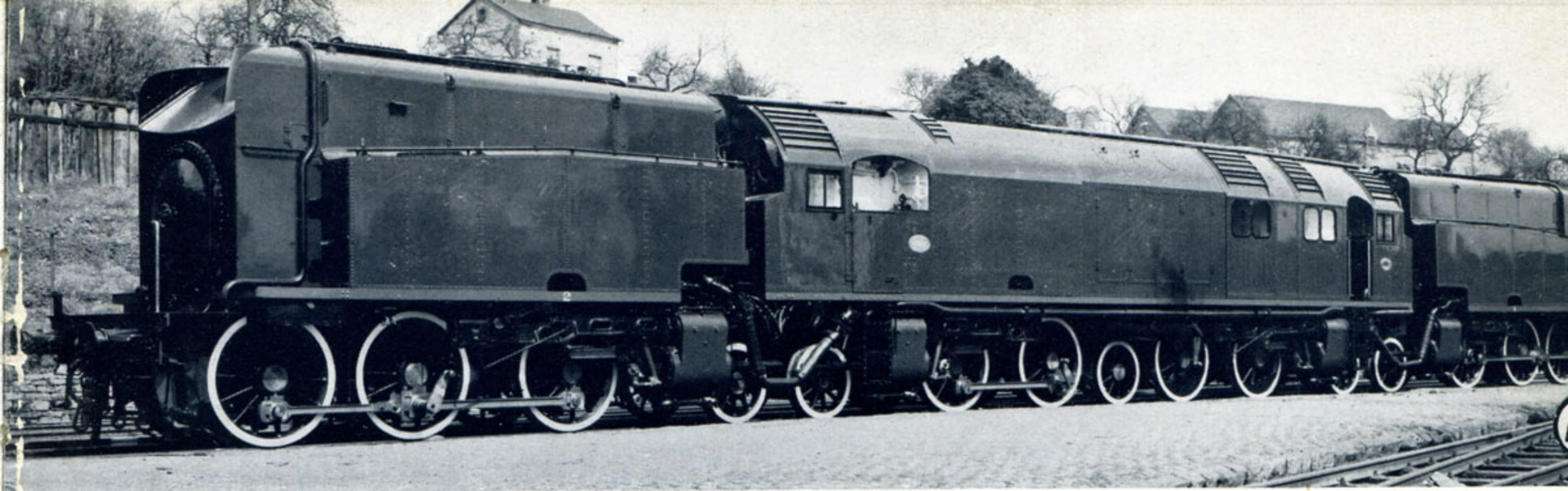
Fig. 59. — Locomotive « Franco » en trois unités motrices à simple expansion. Puissance : 3.000 CV.
