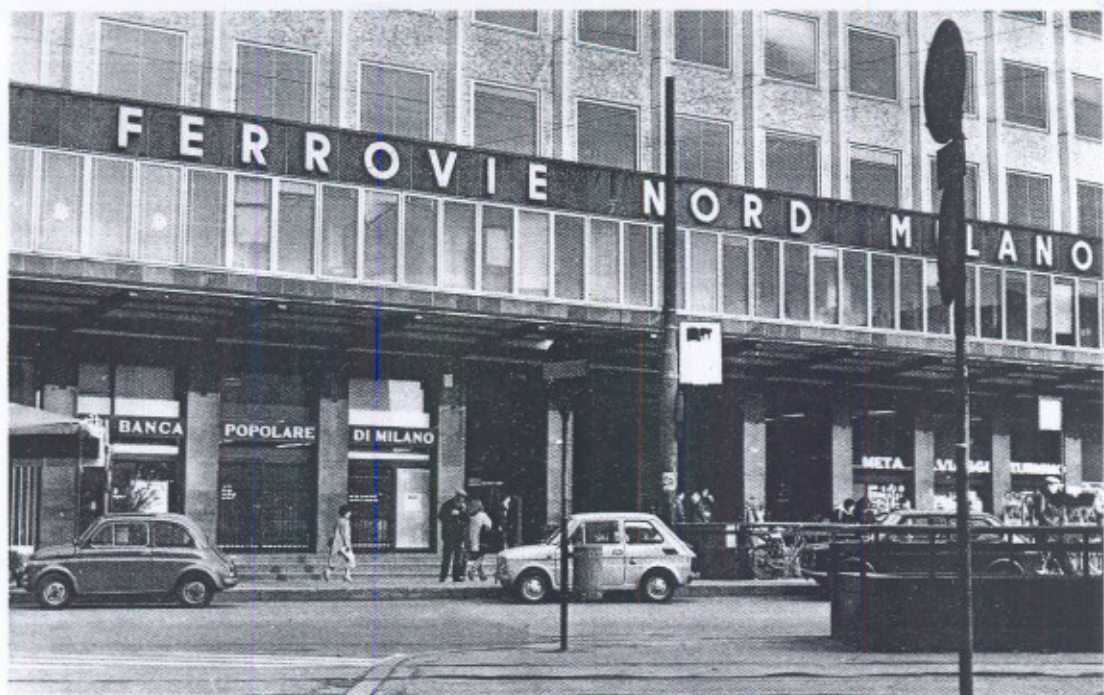
L'ingresso della Stazione di Milano, Piazzale Cadorna.
