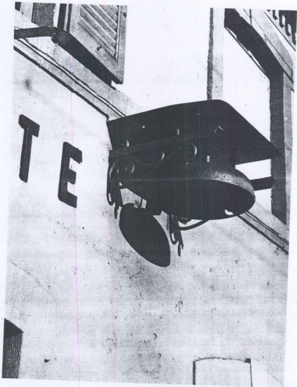
Vecchio segnale a campana in stazione di Malnate, nel 1928. Foto Angelini
